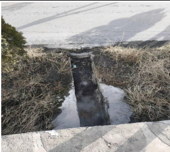
消力池出口管道
