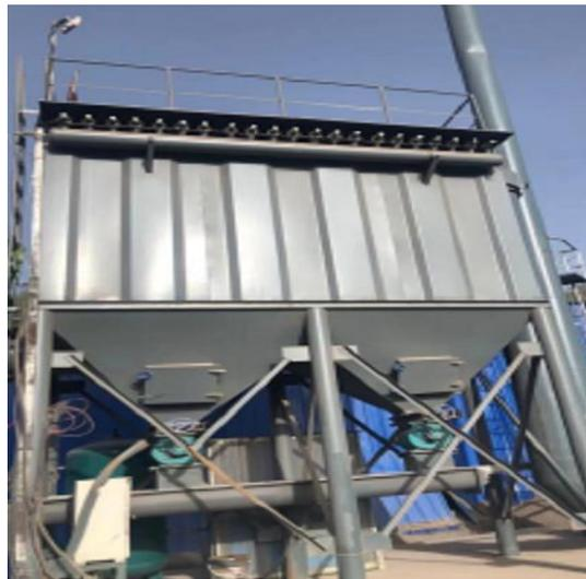
铁精粉給料、筛分除尘器
