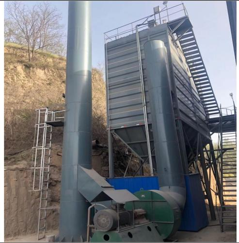
钢渣生产线給料、破碎、除铁、筛分除尘器
