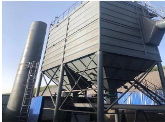
氧化铁皮給料、筛分及成品給料、筛分除尘器
